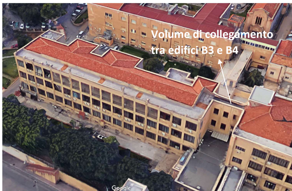
Fig.19. Vista dell'edificio B4 con particolare del volume di collegamento all'edificio B3.
